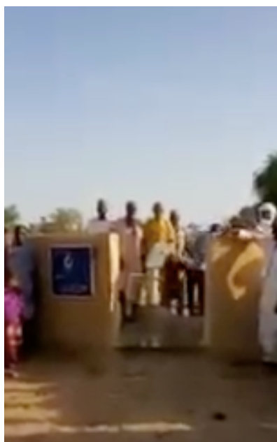
Puits - Village Mai Kassari Début des travaux le 26/04/2021
