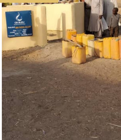
Puits - Village Batse Début des travaux le 08/01/2021
