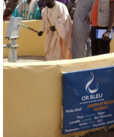
Puits - Village Mai Dikouroum Début des travaux le 14/01/2021
