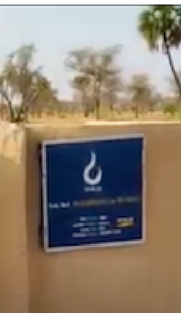
Puits - Village Assarare Début des travaux le 12/04/2021
