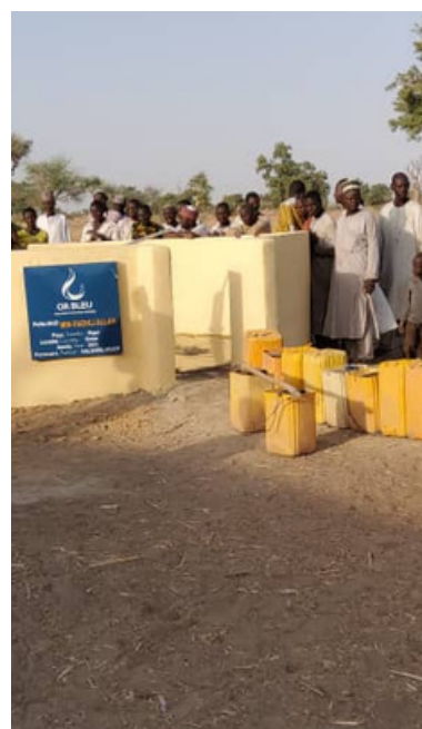
Puits - Village Mai Gamdji Début des travaux le 22/03/2021
