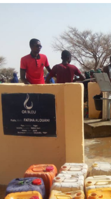
Puits - Village Sabon Gari Début des travaux le 01/03/2021
