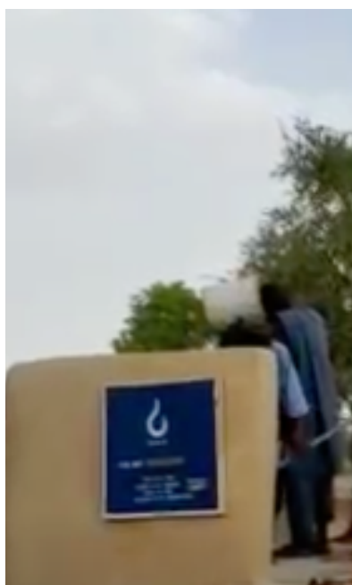
Puits - Village Tagwaye II Début des travaux le 17/03/2021
