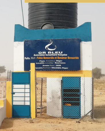
Forage - Village Koumawa Début des travaux le 14/10/2020
